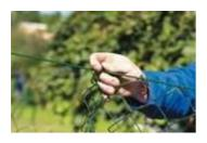
Das Geflecht entlang des Zaunes aufrollen und nach jedem Meter eine Masche in der oberste Reihe Spanndraht einhängen. Das Ende der Geflechtsbahn an die Randlochung der Abspannsäule annähen. Das Geflecht von Abspannsäule zu Abspannsäule spannen und an der Randlochung annähen. Anschließend mit dem Nähdraht das Geflecht zuerst am oberen, dann am unteren und
